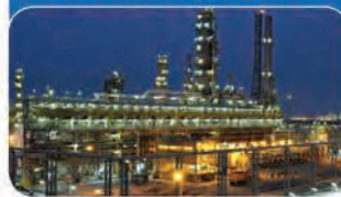
Raslaffan - Olefins Complex - Qatar
