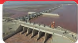
Khanki Barrage - PAK
